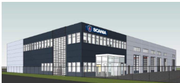
Scania Vaasa, Lujatalo Oy:n urakoima 07/2022. Kiinteistöautomaationa Fidelix.
