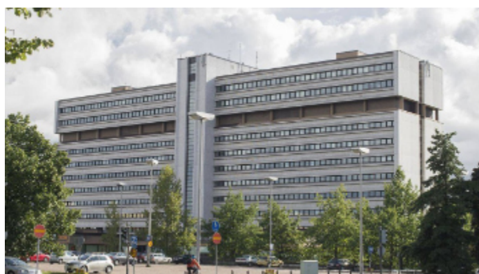
Kouvolan Pohjolatalo 05/2022 Adairiin. Kiinteistöautomaationa Honeywell.
