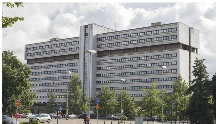
Kouvolan Pohjolatalo 05/2022 Adairiin. Kiinteistöautomaationa Honeywell.
